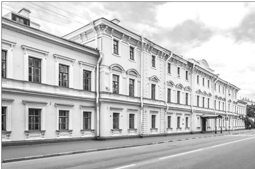
• Здание Театра Балтийского флота.
