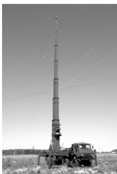
Станция на полигоне.
