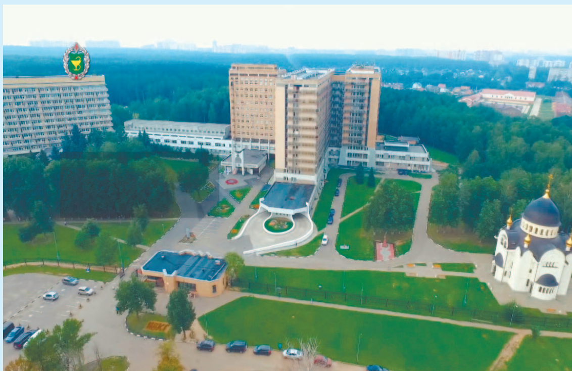
Панорамный вид на корпуса госпиталя с высоты птичьего полета
