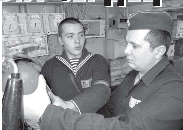
Проверка знаний средств пожаротушения дозорного по живучести матроса Р.Кузнецова.
