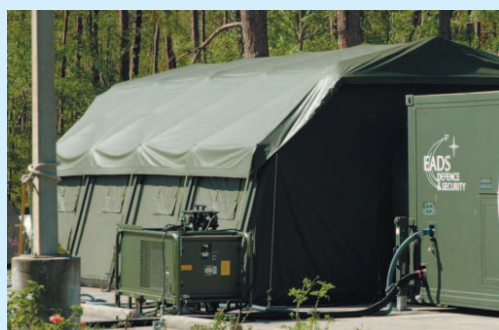
Пневмокаркасная палатка с наружным каркасом и солнцезащитным тентом (EADS, Германия)
