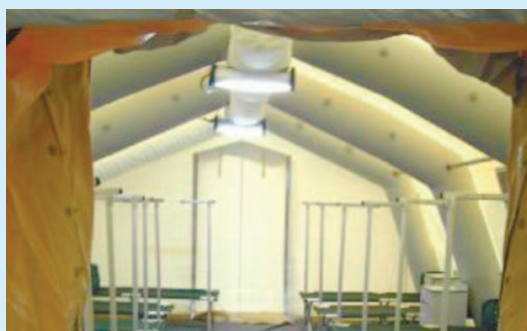
Внутренний вид пневмокаркасного укрытия (Zeppelin, Германия)
