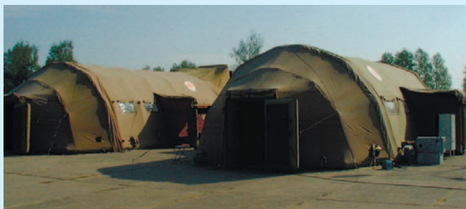
Пневмокаркасное сооружение ПСМ-6 с внутренним каркасом (Россия)
