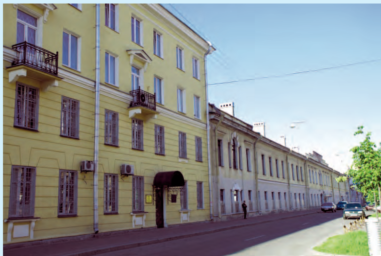
Санкт-Петербург, Захарьевская, 8. Комплекс зданий «Придворно- конюшенного ведомства», в котором Главное военно- медицинское управление находилось с 1867 г.
