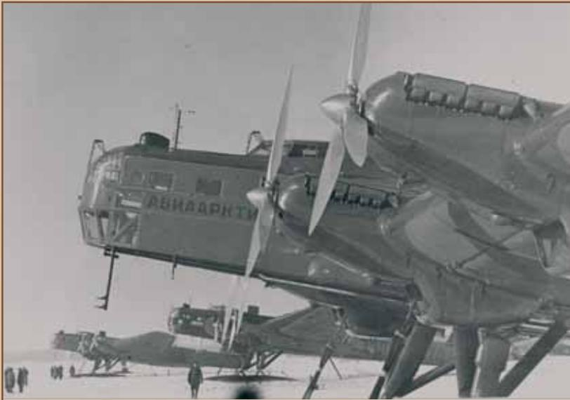
Самолет АНТ-6 «Авиаарктика», специально утепленный и переоборудованный М. Водопьяновым для полета высокоширотной арктической экспедиции на Северный полюс.
