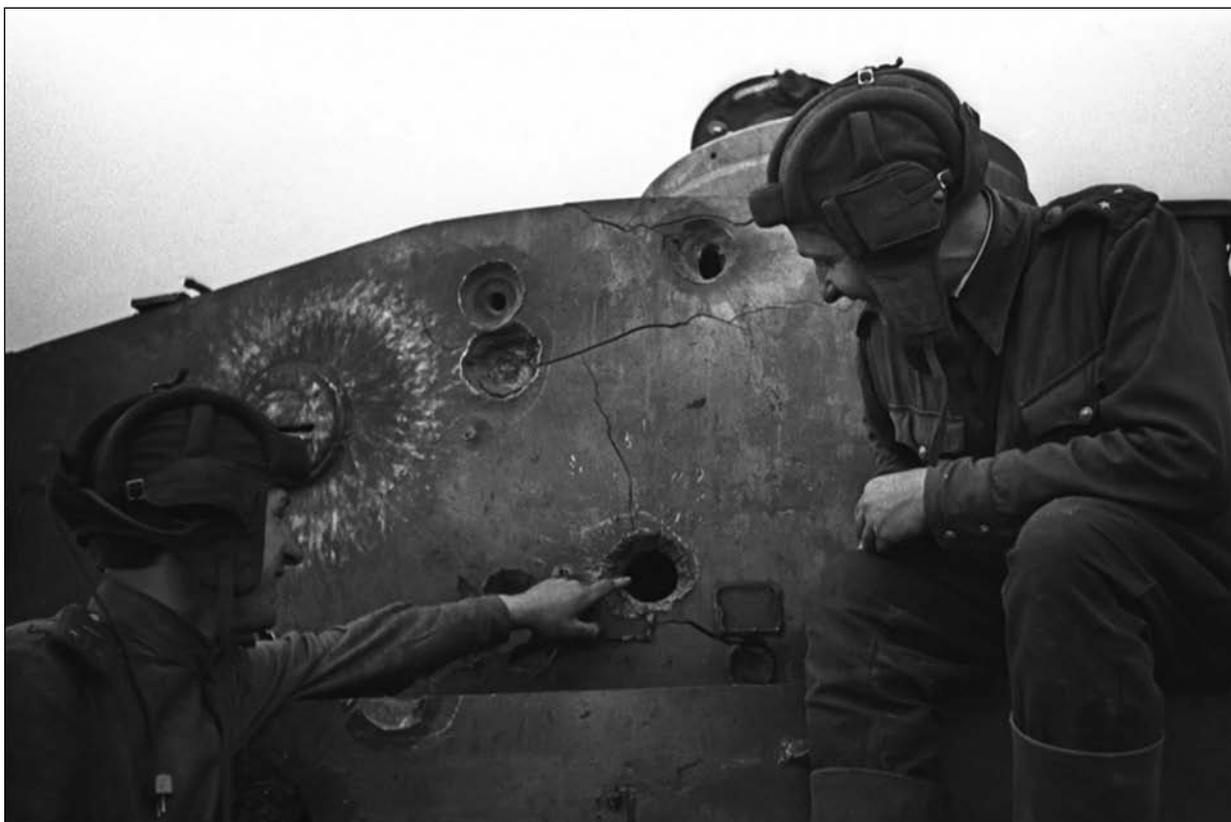
*Командир танка лейтенант Б.В. Смелов показывает пробоину в башне немецкого танка «Тигр», подбитого экипажем Смелова, лейтенанту Лихнякевичу (подбившему в последнем бою 2 фашистских танка). Эту пробоину сделал обычный бронебойный снаряд из 76-миллиметрового танкового орудия. 1943 год*
