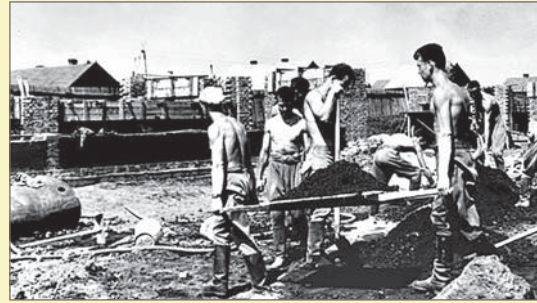
Курсанты училища на строительстве военного городка в Тамбове 1948 г.
