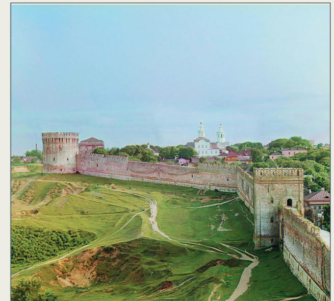
Вид на крепостную стену с башни Веселуха в 1912 г.
